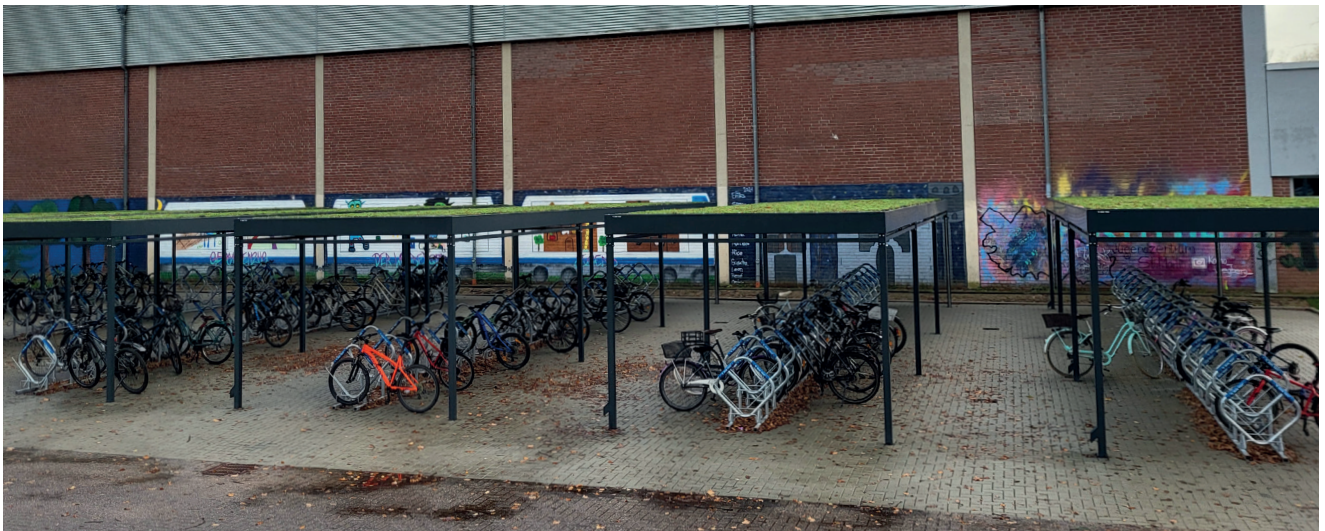
Fahrradabstellanlage an einer Schule mit mit Grünbedachung für 336 Fahrräder, 5 Einheiten in Reihe Ausstattung: LED-Beleuchtung und Fahrradständern Prisma®
