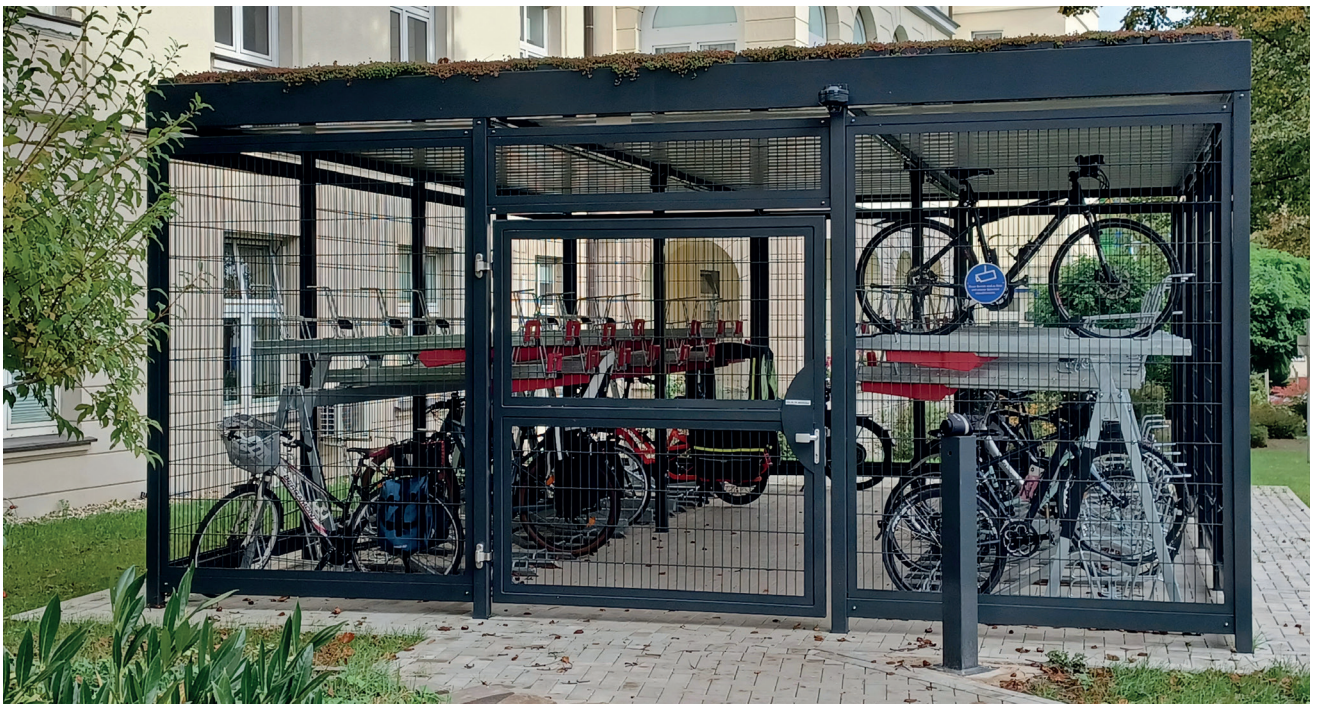
Fahrradabstellanlage mit Grünbedachung für 32 Fahrräder Ausstattung: Rück- und Seitenwände und elektrische Drehtür aus Doppelstabgittermatten, LED-Beleuchtung mit Bewegungsmelder und Doppelstockparksystem. Zugangssystem RFID Chipkartenleser an Zugangssäule.
