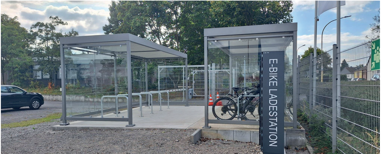
Fahrradabstellanlage für 20 Fahrräder, 2 Einheiten gegenüber Ausstattung: Rück- und Seitenwände aus Einscheibensicherheitsglas, Ladestation Tower, Anlehnbügel Erkelenz
