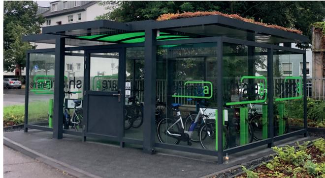
Geschlossene Fahrradüberdachung Tectum mit Dachbegrünung
