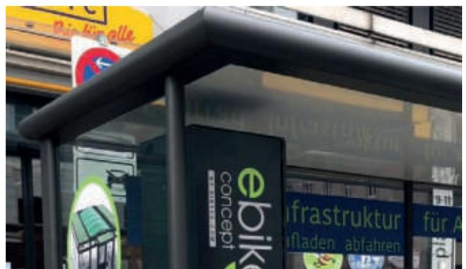
Detail Dachrand- und Stützprofil in DB 703 eisenglimmer grau pulverbeschichtet
