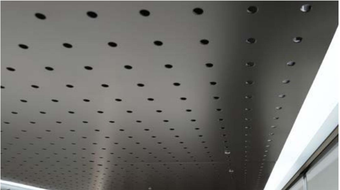
Beim Eintreten in die Kabine wird die stromsparende LED-Deckenbeleuchtung gestartet und die Abluftanlage vom Stand-by in den Vollast-Modus geschaltet.
